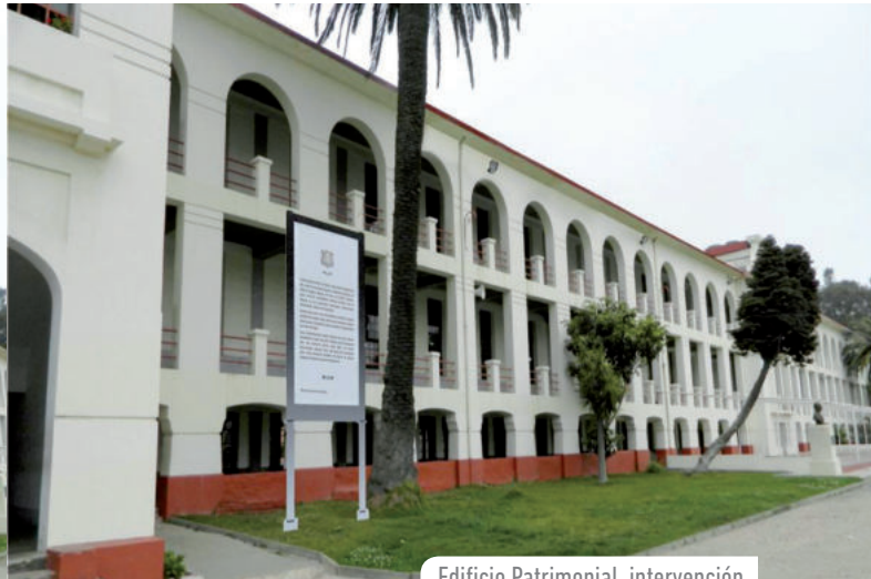
Edificio Patrimonial, intervención
